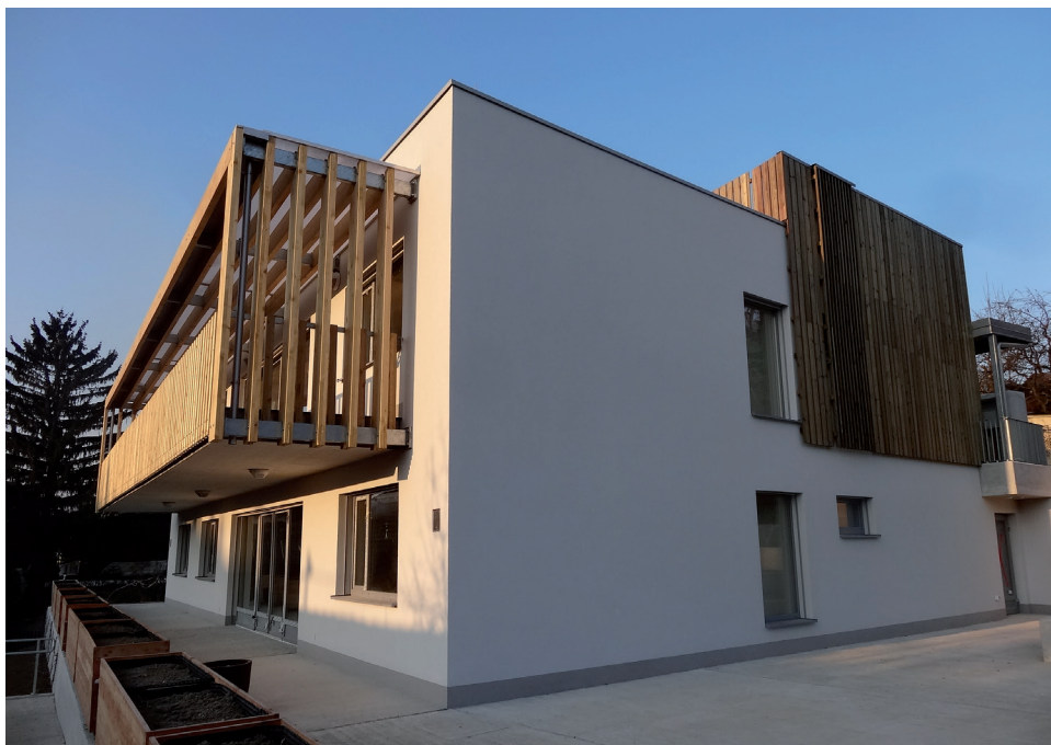
Dvonadstropna stavba - v vsakem nadstropju ena stanovanjska enota (arhiv JSS MOL)
