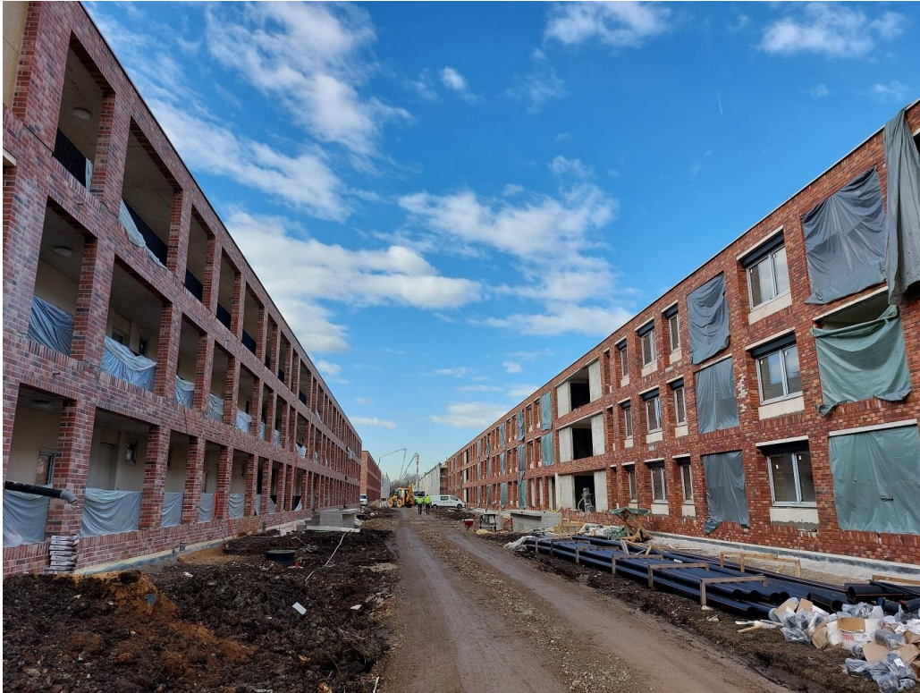
Gradbišče stanovanjske soseske Rakova jelša II (fotografija VG5 d.o.o., oktober 2021)
